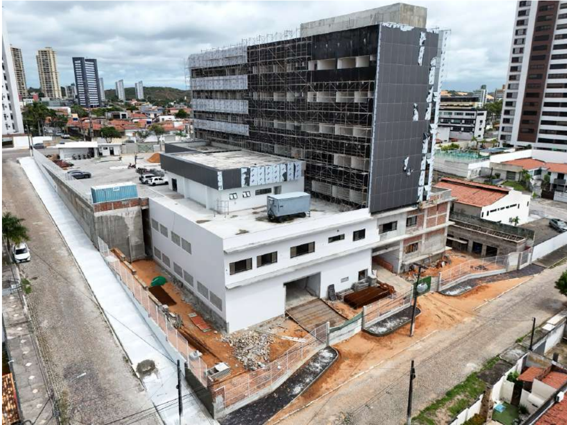
Figura 8 Instalação do ACM na fachada frontal e lateral sul da edificação.
