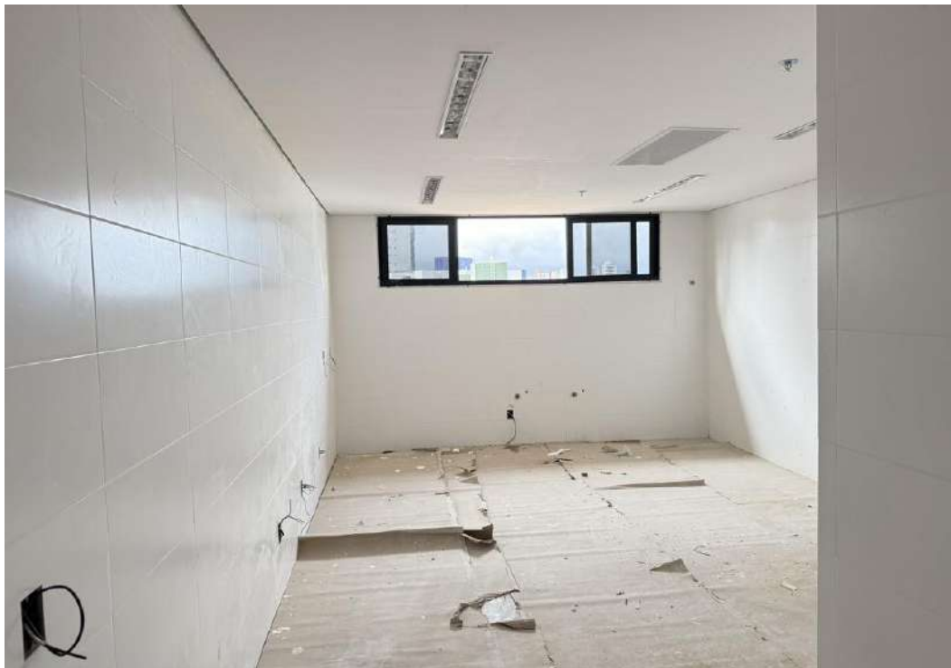
Figura 12 - Aplicação do forro drywall na copa do pavimento semienterrado 1.
