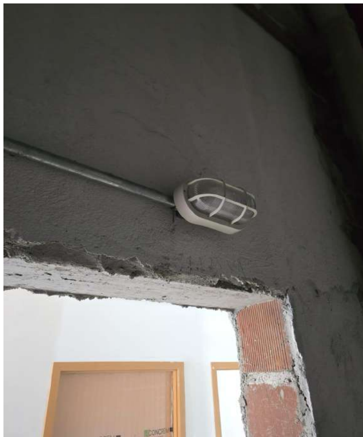
Figura 37 Instalação das luminárias tipo arandela.
