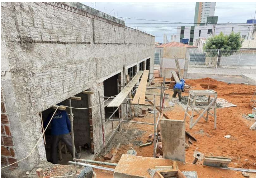
Figura 3. Execução da alvenaria da Casa do lixo
