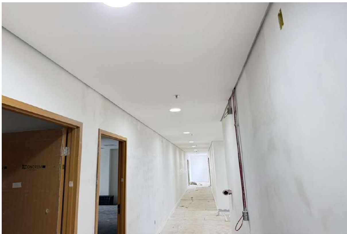
Figura 19 Emassamento de paredes e teto.
