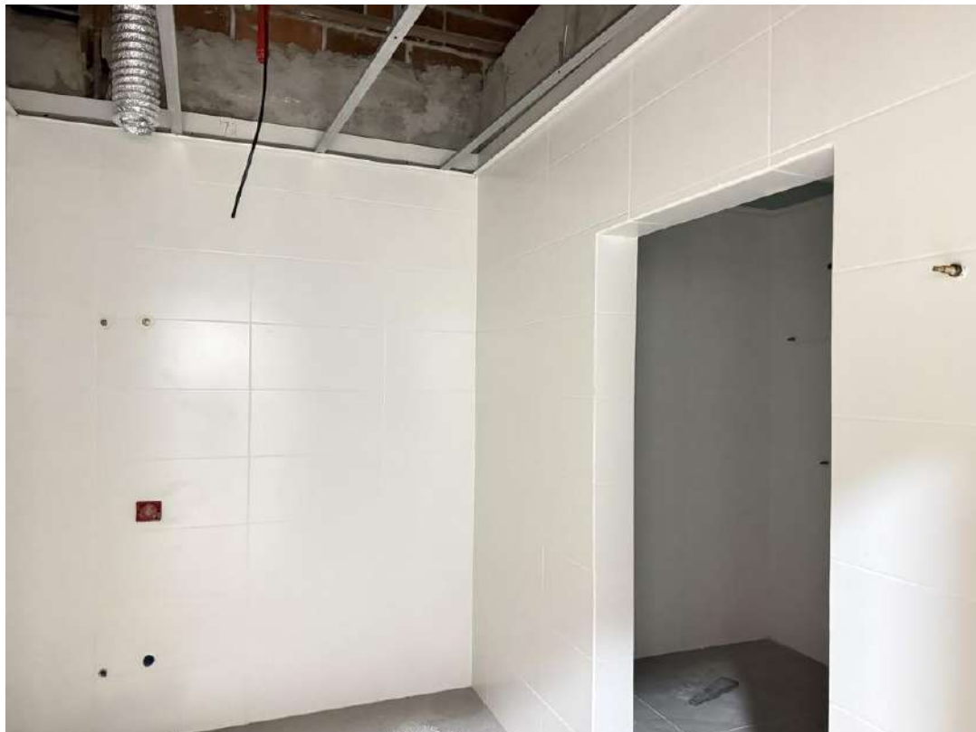
Figura 10 Instalação do revestimento cerâmico de parede nos banheiros PCD do pavimento primeiro semienterrado.
