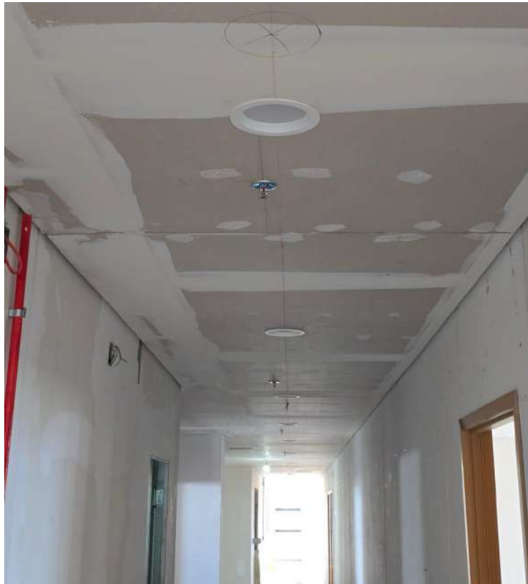
Figura 36 Instalação das luminárias em LED circulares.
