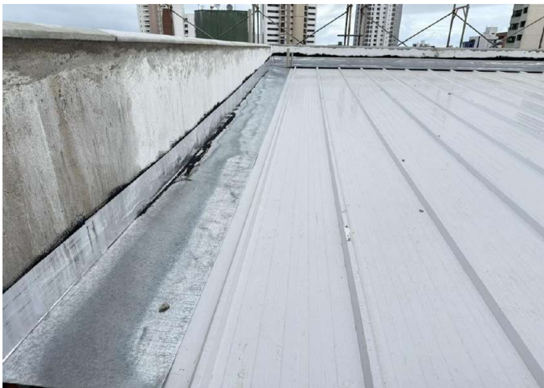
Figura 14 Instalação dos rufos na cobertura da edificação.
