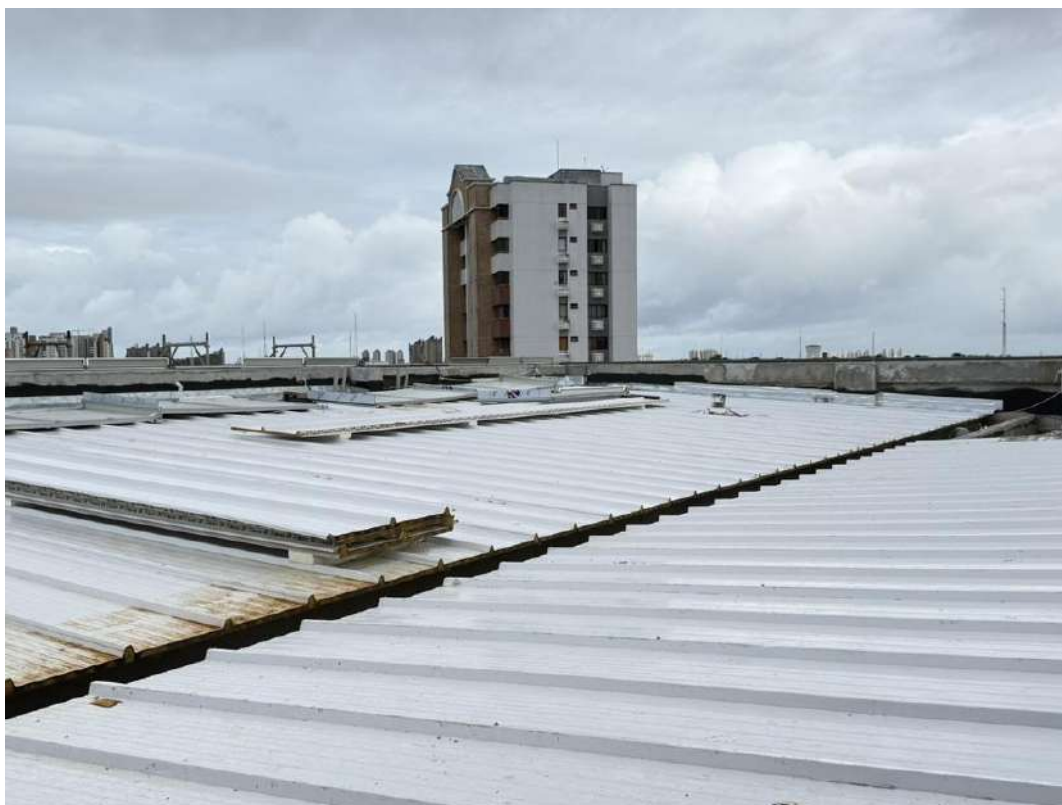
Figura 13 - Aplicação da telha trapezoidal de alumínio.
