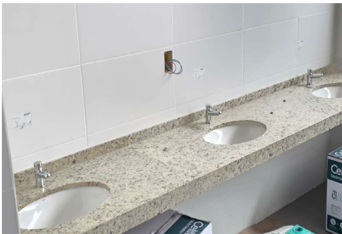
Figura 21 Instalação das torneiras de bancada.
