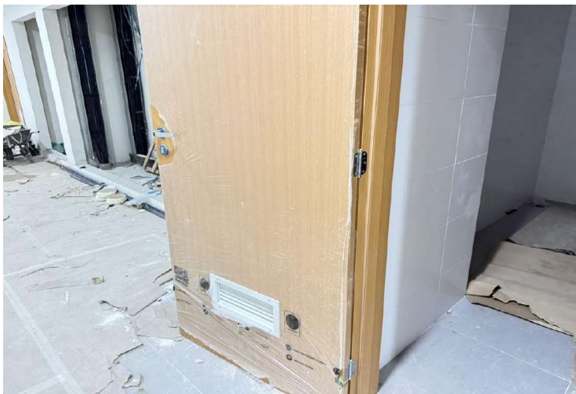
Figura 15 - Instalação das portas nos banheiros PCD.
