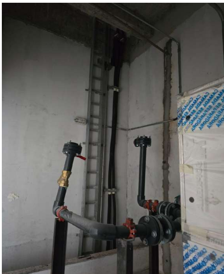
Figura 40 - Ligações típicas Fancoil.
