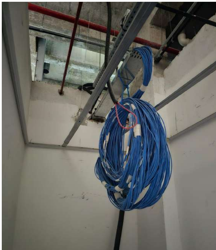
Figura 38 - Cabeamento Estruturado. Instalação de cabos UTP na sala de racks.
