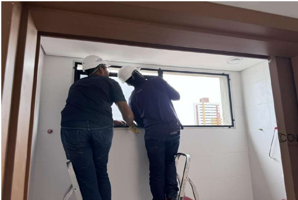
Figura 16 Instalação das janelas nos banheiros PCD.
