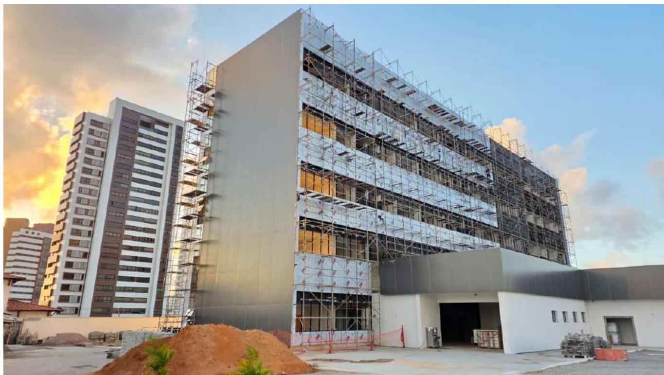
Figura 1. Visão geral da obra.
