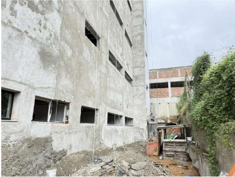
Figura 6 Execução de chapisco e emboço na fachada da edificação.
