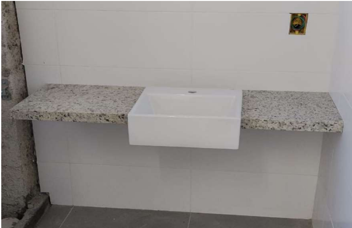
Figura 22 Instalação das bancadas para banheiros PCD.
