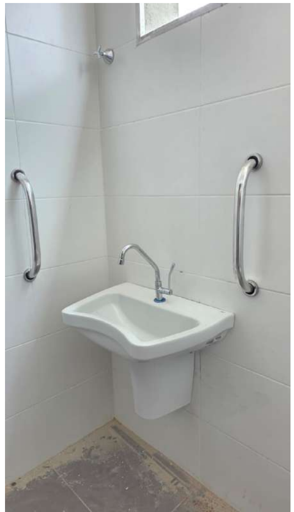
Figura 24 Instalação de pia, torneira e barras de apoio em banheiro PCD.
