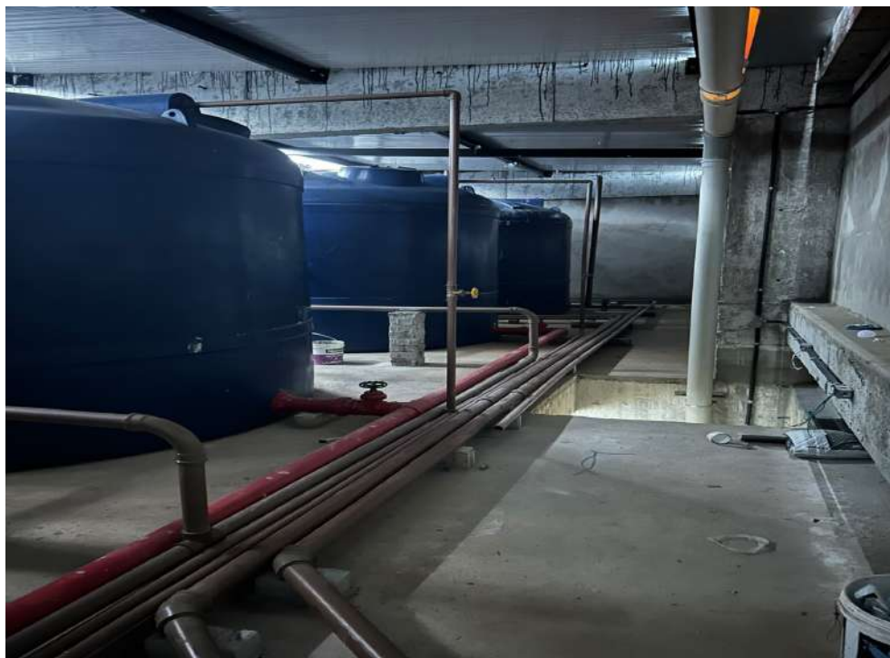
Figura 29 Tubulação de água fria.
