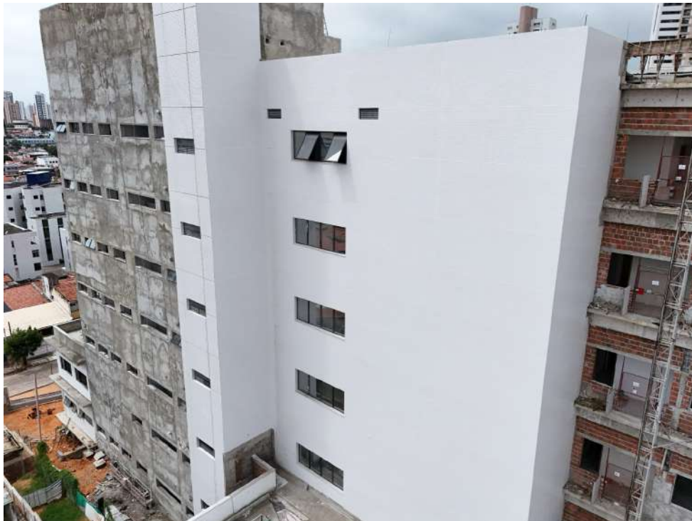
Figura 7 Aplicação de revestimento cerâmico na fachada oeste da edificação.
