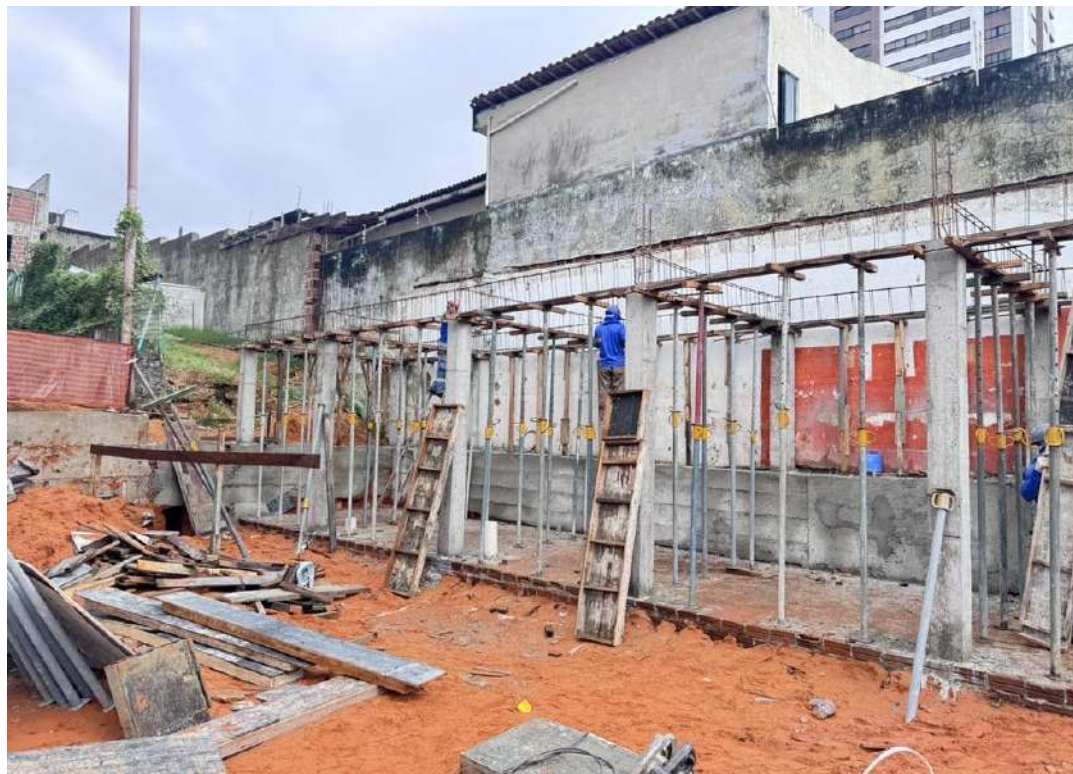
Figura 2. Execução da estrutura da Casa do lixo.
